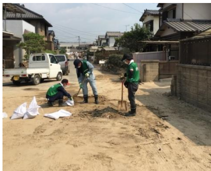
堆積土砂の撤去
